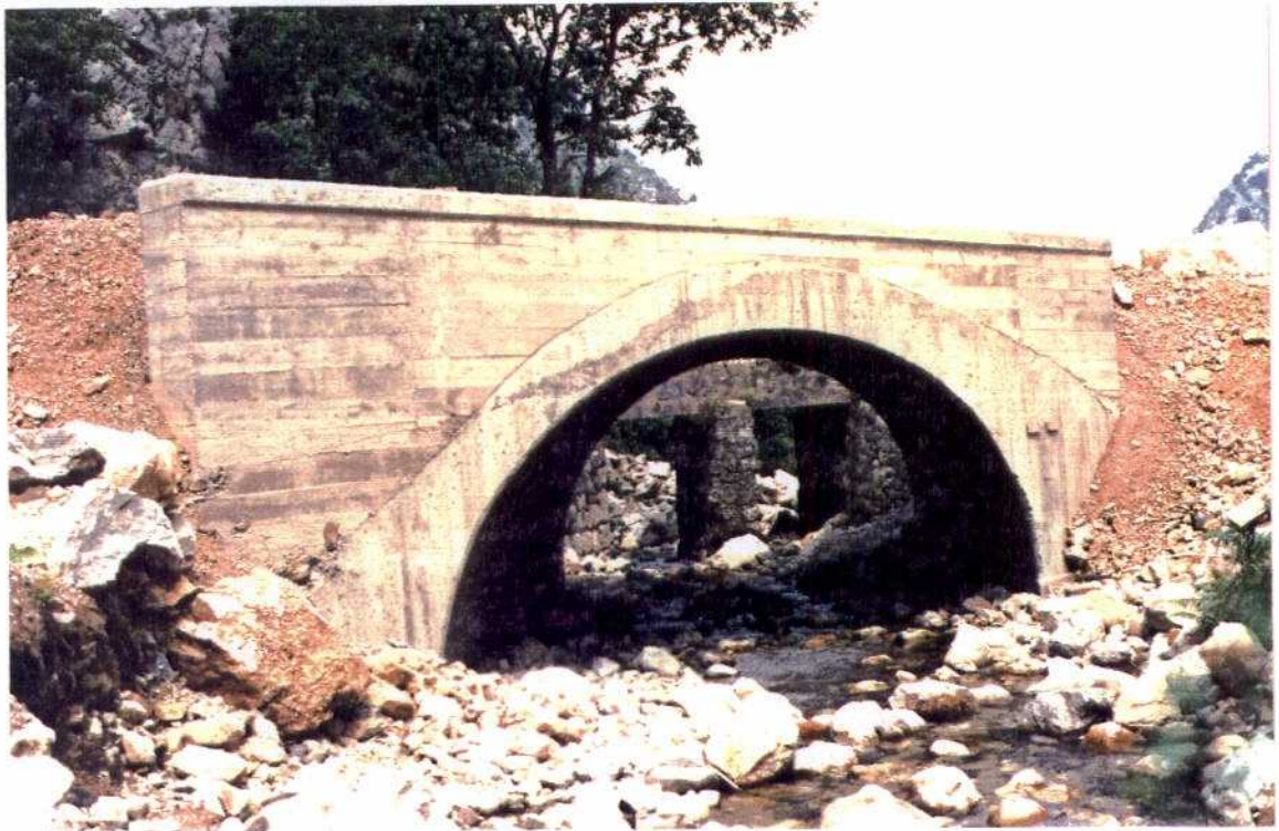
Fotografía nº5.- Puente antiguo (al fondo), en la ruptura de pendiente del arroyo y puente nuevo (delante).
