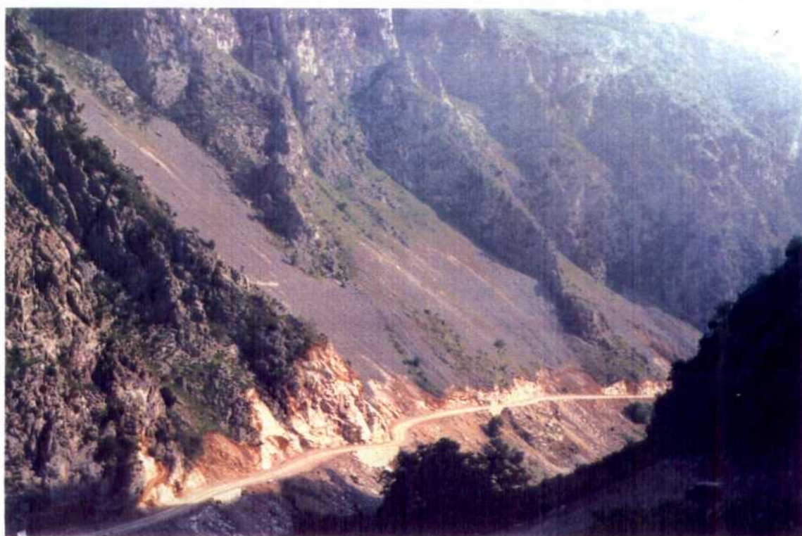
Fotografía nº 11.- Vista general del valle desde las proximidades de la Iglesia de Beges. Observar el trazado de la nueva carretera y la desestabilización de canchales.
